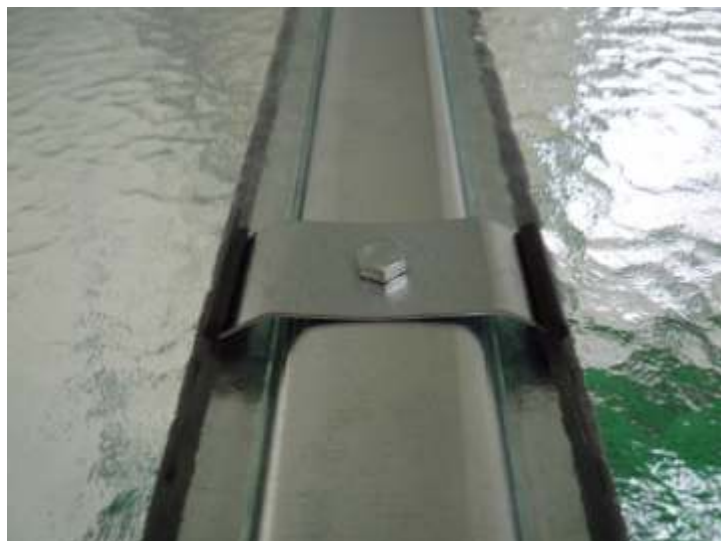
Přichycení střešního skla příchýtkou poz. 83-2. Pod tyto příchýtky můžeme zevnitř skleníku umístit vyvazovací pásy, pozice 84-2
