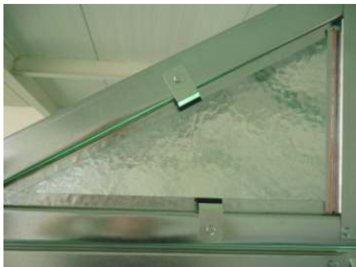
Přichycení střešního skla příchýtkou poz. 83-2. Pod tyto příchýtky můžeme zevnitř skleníku umístit vyvazovací pásy, pozice 84-2
