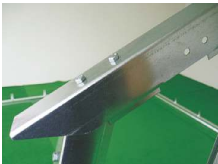
Montáž horního levého rohového (střešního) sloupku (poz. 6, 8, 55 pomocí šroubů M6x25)
