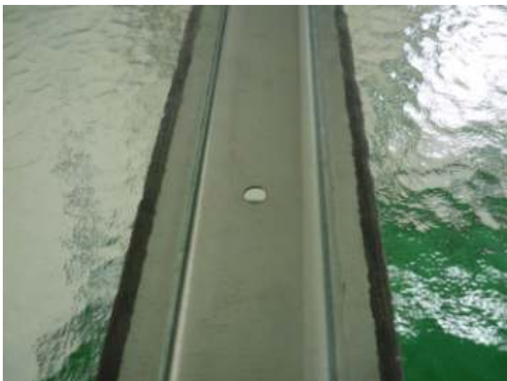
Přichycení střešního skla příchýtkou poz. 83-2. Pod tyto příchýtky můžeme zevnitř skleníku umístit vyvazovací pásy, pozice 84-2
