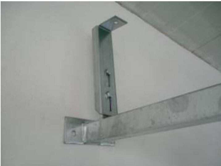
Montáž výztuhy hřebene (poz. 33) k jácklové výztuže.
