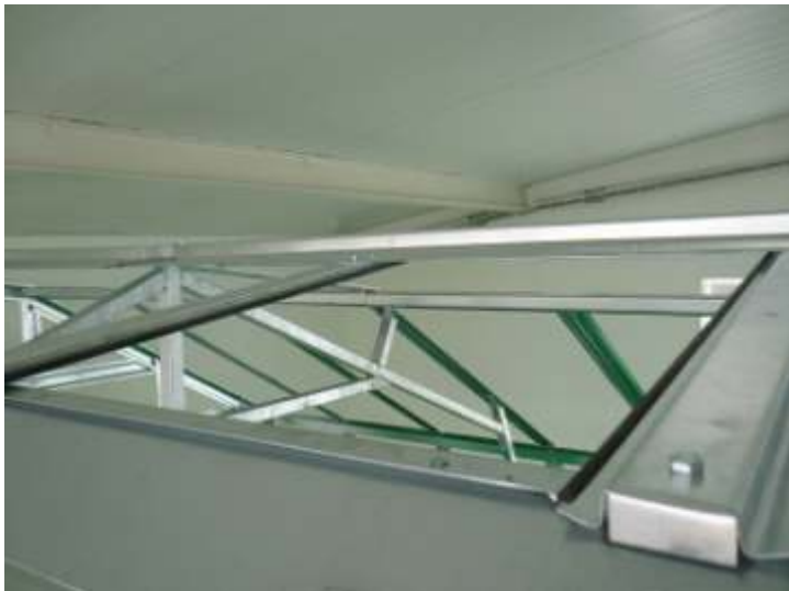
Detail zasklení hřebenové části.
